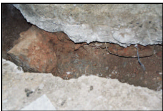
Làmina 4: Mur U.E 104. 009/04-1
