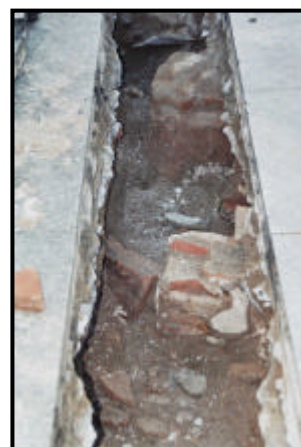
Làmina 6: Mur U.E 108. 009/04-8
