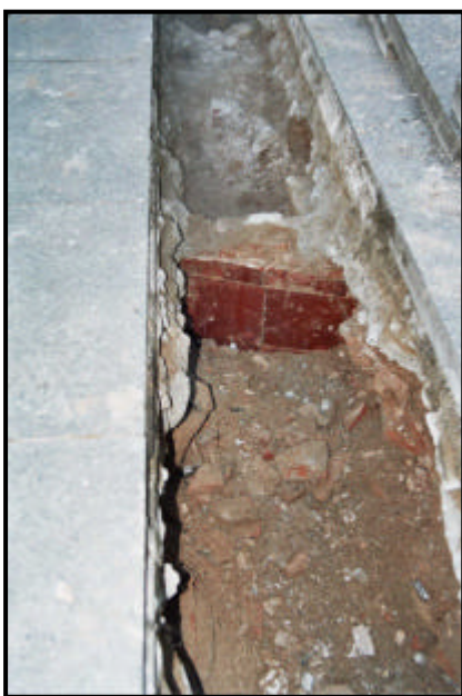
Làmina 7: Mur U.E 107. 009/04-7
