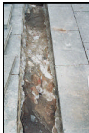
Làmina 5: Mur U.E 107. 009/04-6
